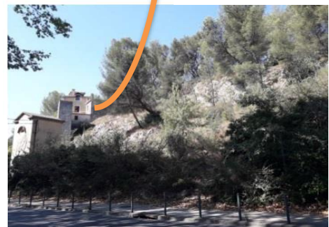
La propriété au-dessus de la station de pompage aujourd'hui
