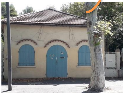
La boule Saint-Eutrope (ex-station de pompage)
